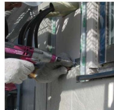
サイディング施工
