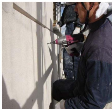
パワーボード施工
